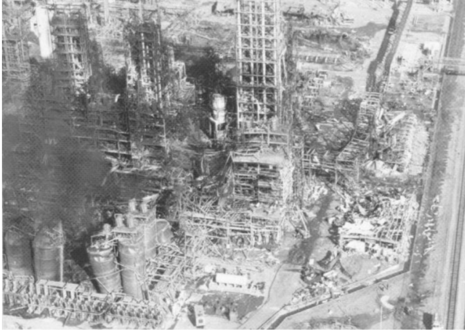
Zustand Chemieranlage nach erfolgter Gasexplosion
